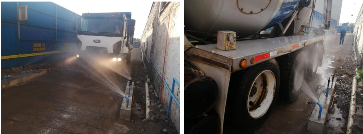
❖ fotografías: zona de lavado de ruedas.
